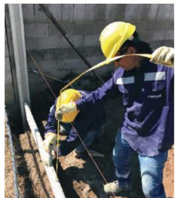
5. Rellenar el pozo de la columna con hormigón pobre H13 de bajo asentamiento, hasta una altura de 10 cm antes de llegar a la cota de nivel del suelo, mediante pisón compactar el hormigón para asegurar la verticalidad de la columna.
