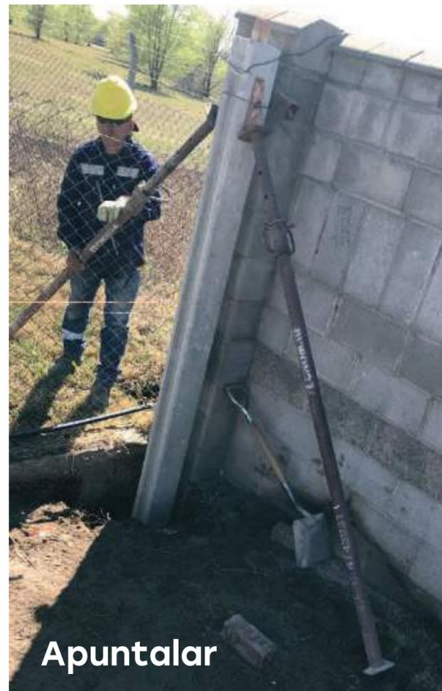
4. Colocar la primera placa inferior, la cual se utilizará de guía para ubicar la segunda columna del tramo. Verificar niveles. Posteriormente ubicar y apuntalar la siguiente columna del tramo.
