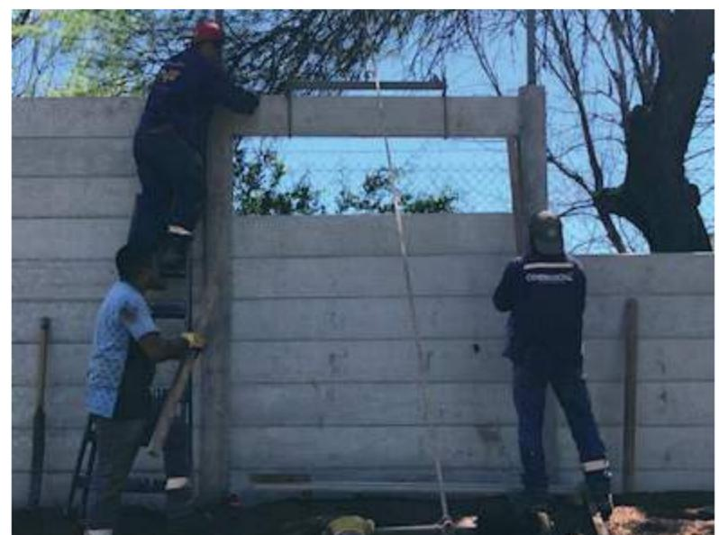
11. Finalmente, se deberán rellenar los huecos de las columnas con material de relleno (hormigón) para evitar el ingreso de agua.
